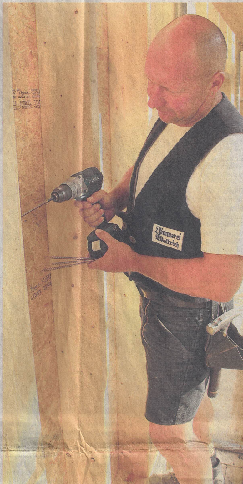
Udo Weltrich von der gleichnamigen Firma aus Goßwitz bei Arbeiten am neuen Feuerwehrgerätehaus in Leutenberg. Foto: Wolfgang Schombierski
