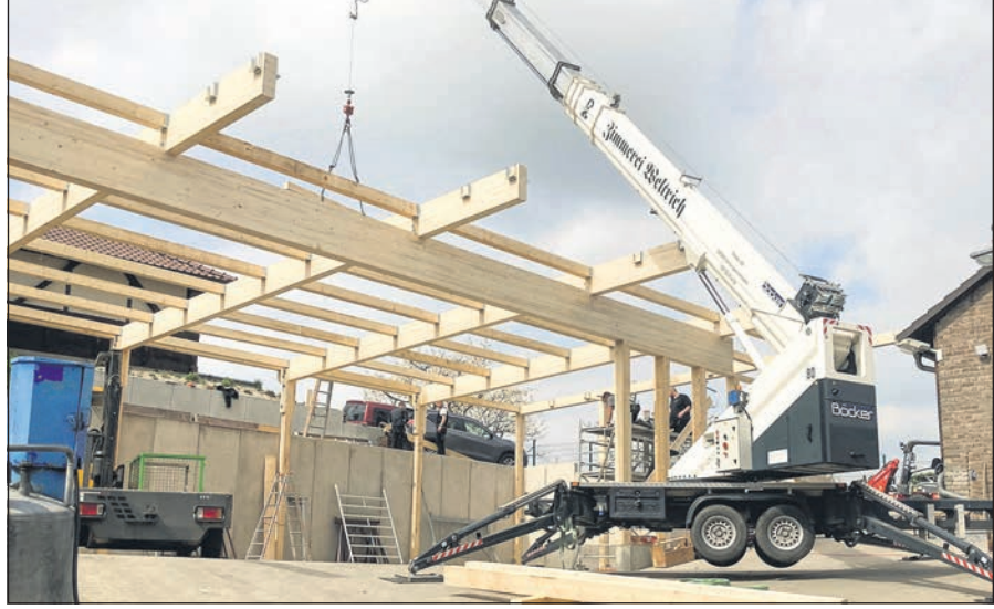
Neubau Halle Firmengrundstück. Foto: Zimmerei Weltrich
